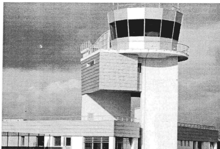
La torre di controllo dell'aeroporto Magliocco
